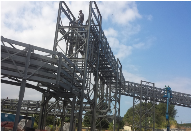
Passarela com vão livre 18m - Águas do Brasil - Paraty -RJ
