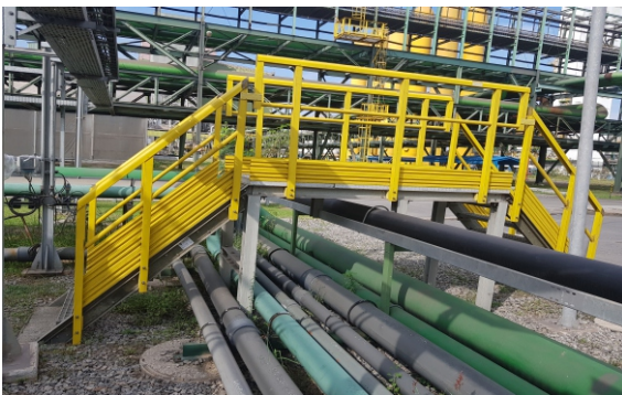
Maior Estrutura em Fibra de Vidro Pultrada da América Latina - ( Mais de 5km de Cable Rack - Porto Sudeste - RJ)
