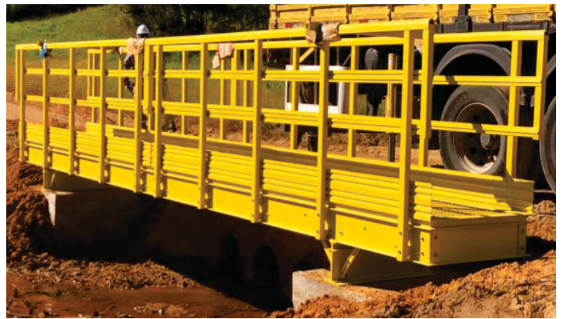
Passarela - Cabiunas Petrobrás
