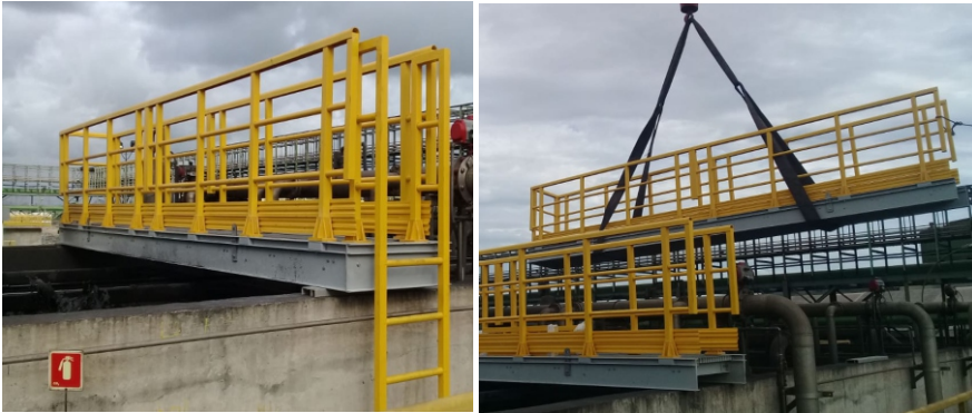
Passarela de Transposição de Dutos e de Acesso a Válvulas e Instrumentação - Petrobrás
