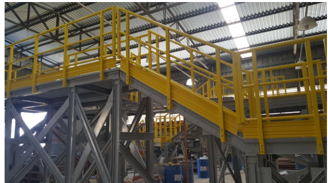
Maior Estrutura em Fibra de Vidro Pultrada da América Latina - ( Mais de 5km de Cable Rack - Porto Sudeste - RJ)
