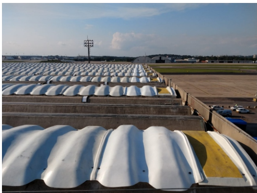
Cobertura Terminal Galeão
