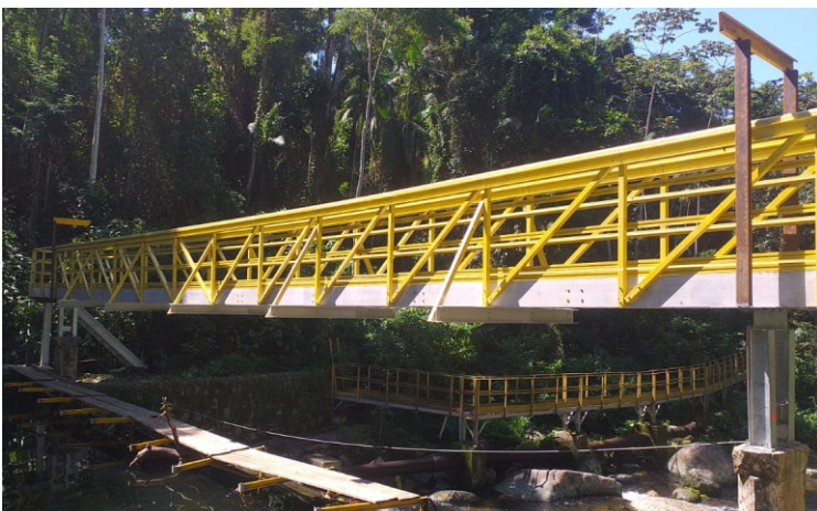
Passarela com vão livre 18m - Águas do Brasil - Paraty -RJ
