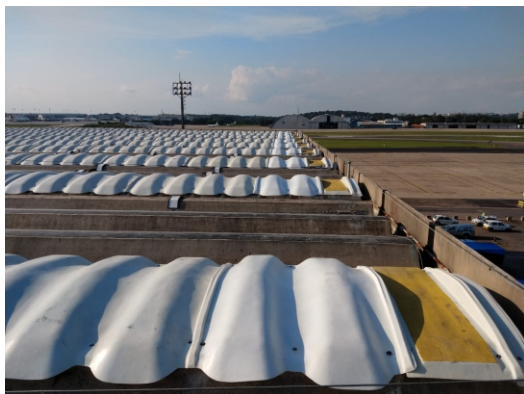
Cobertura Terminal Galeão
